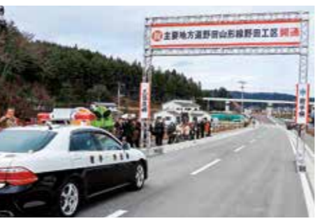
主要地方道野田山形線野田工区 開通 (平成30年12月25日)
