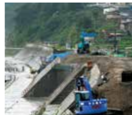
久慈市久喜漁港海岸災害復旧工事(平成25年9月)
