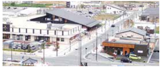
陸前高田市高田南地区津波復興拠点整備事業をはじめとする関連事業により整備を進めた中心市街地の様子(平成30年9月)
