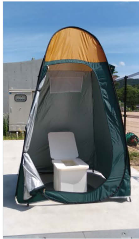
▲マンホールトイレを設置した状態
