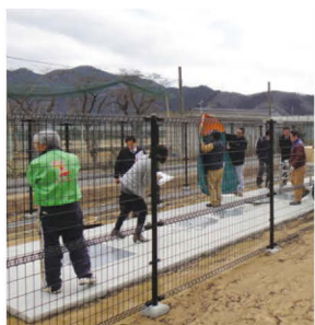
▲災害防災設備説明会では、マンホールトイレ設置状況を確認
