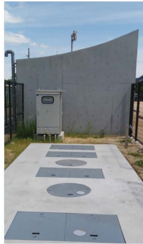
▲マンホールトイレに対応した浄化槽(PCN型105人槽)
