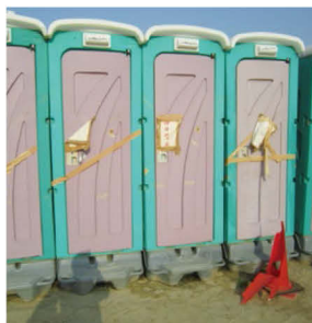
▲災害時、バキュームカー不足で使用できなくなった仮設トイレ
