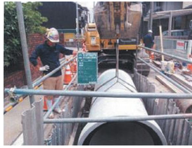
下水管の改築にあわせた能力増強
