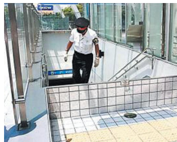
地下鉄の起上方式止水板
