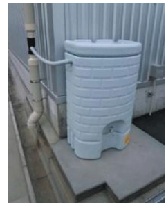
雨水タンクの設置
