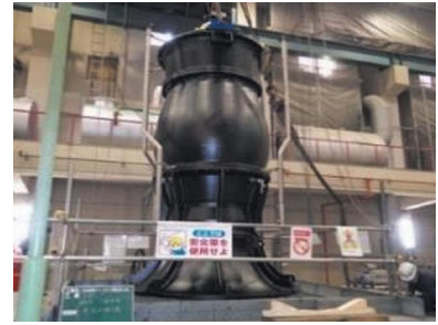
ポンプ施設の改築にあわせた能力増強
