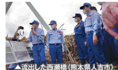
▲流出した西瀬橋（熊本県人吉市） 7月15日 赤羽国土交通大臣の視察 (人吉市西瀬橋) (国土交通省九州地方整備局HPより)
