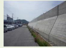
海岸堤防の耐震補強などの地震・津波対策
