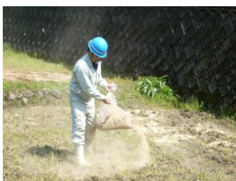
流出油による土壌汚染の浄化(生分解)工事
