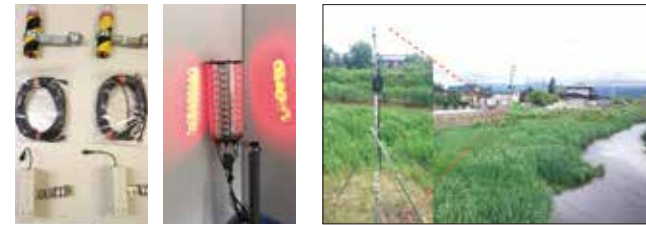
(国土交通省) 河川増水危険警告灯を 全国に先駆けて試験運転開始
