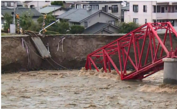
落橋した千曲川橋梁
