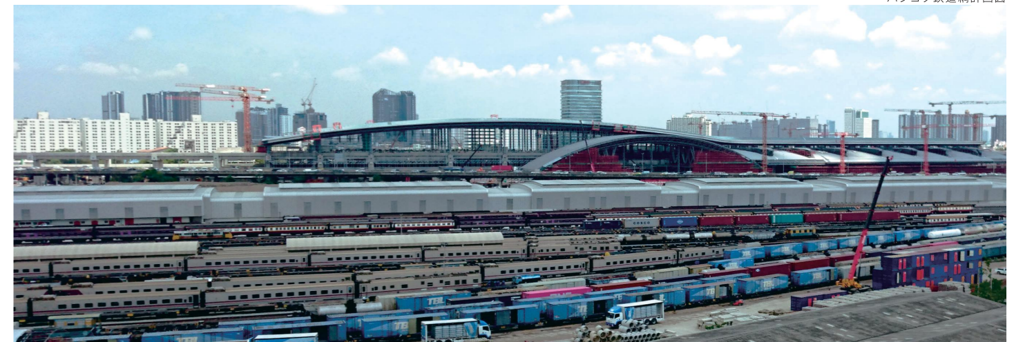
建設中のバンサー中央駅
