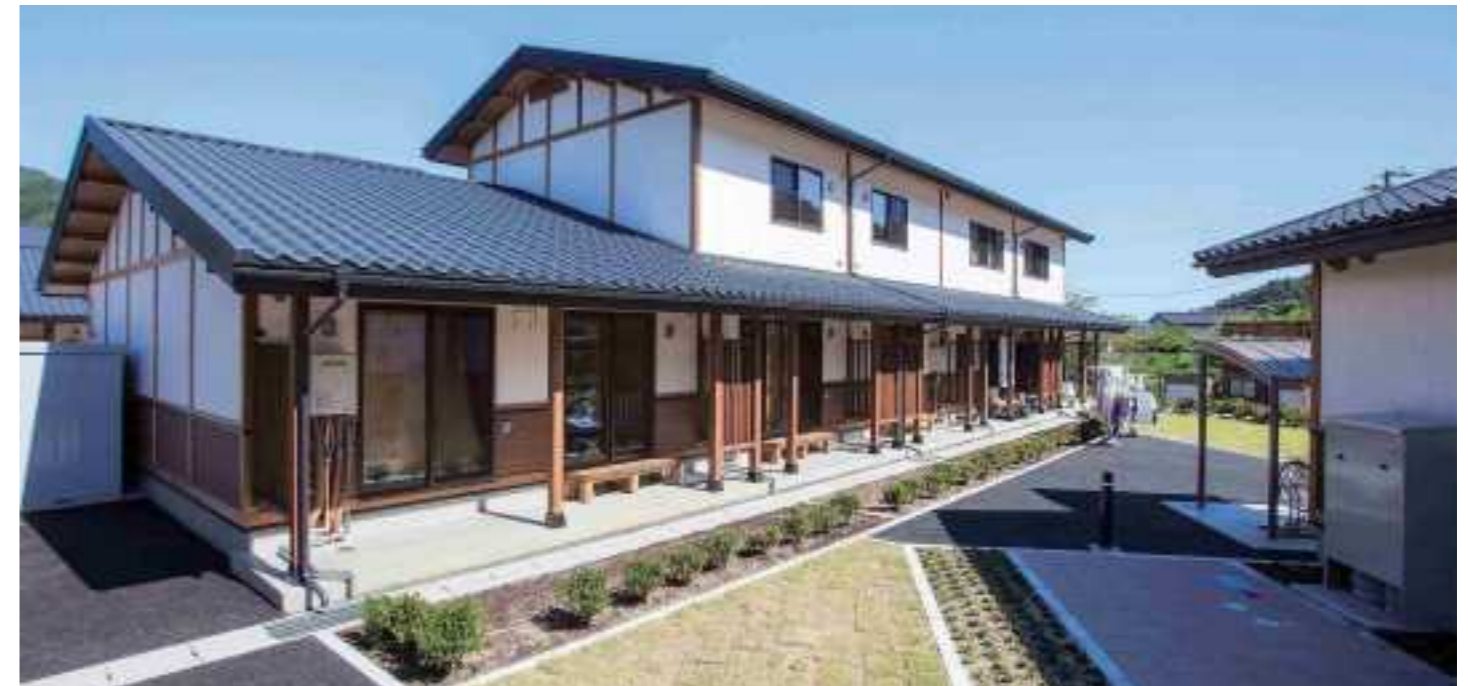
大ケロ一丁目町営住宅
