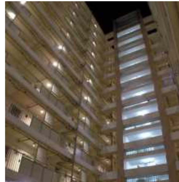
共用照明のLED化
