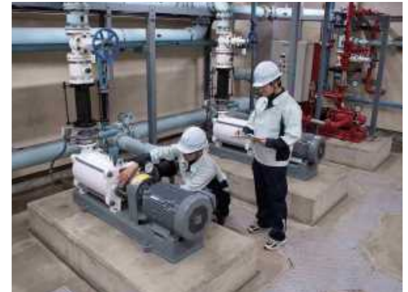
給水施設の点検
