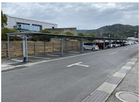
太陽光発電システム (カーポートタイプ)
