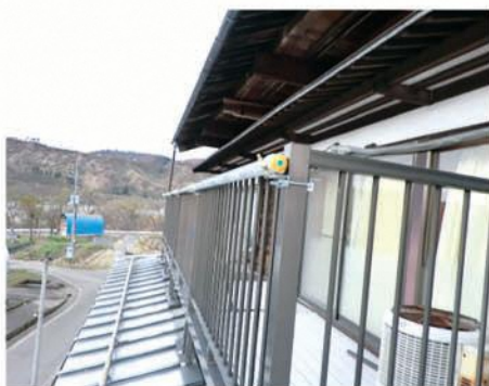
単管パイプを使用
