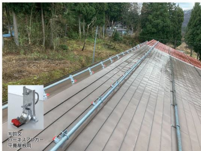
平葺き金属屋根に取付。
