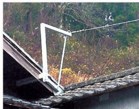
破風に金具を取り付け
