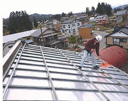
列状に単管パイプを配置
