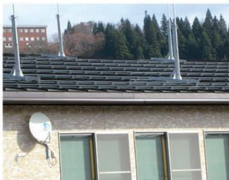
支柱に直接命綱を固定する
