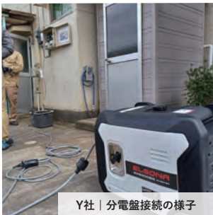
Y社 | 分電盤接続の様子
