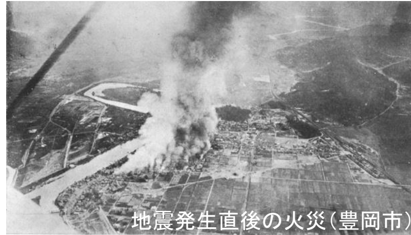
地震発生直後の火災(豊岡市)
