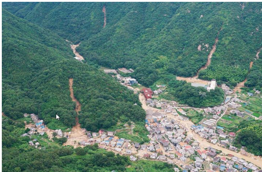
2018 年 7 月 6 日 西日本豪雨災害 広島県呉市天応地区 【出典】平成 30 年豪雨災害（広島県土木建築局砂防課） https://www.sabo.pref.hiroshima.lg.jp/portal/sonota/sabo/pdf/234_H30_7g_ouusaigai.pdf より
