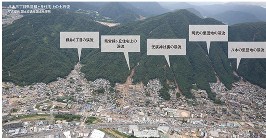
2014 年 8 月 20 日 広島市豪雨土砂災害 緑井・八木地区 【出典】 https://www.projectdesign.jp/201410/flood-control/002235.php より
