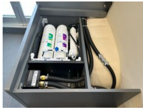
逆浸透膜を使った浄水フィルター
