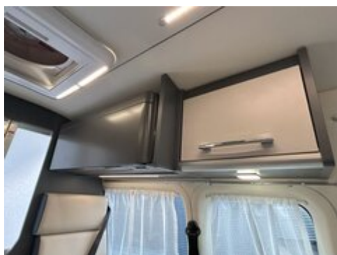
家庭用エアコン
