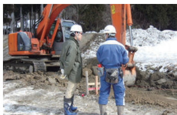
林道整備の現場に立会う職員
